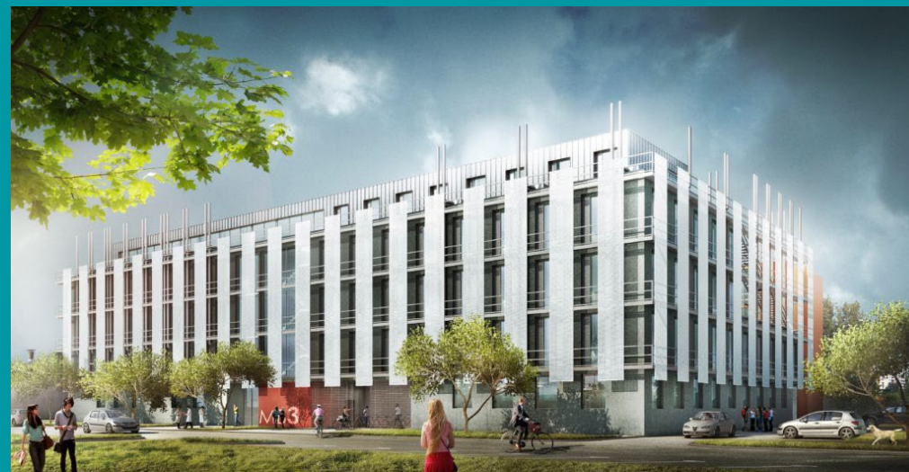
Construction des laboratoires MB3 - INSA de Toulouse | © ALS Architecture
